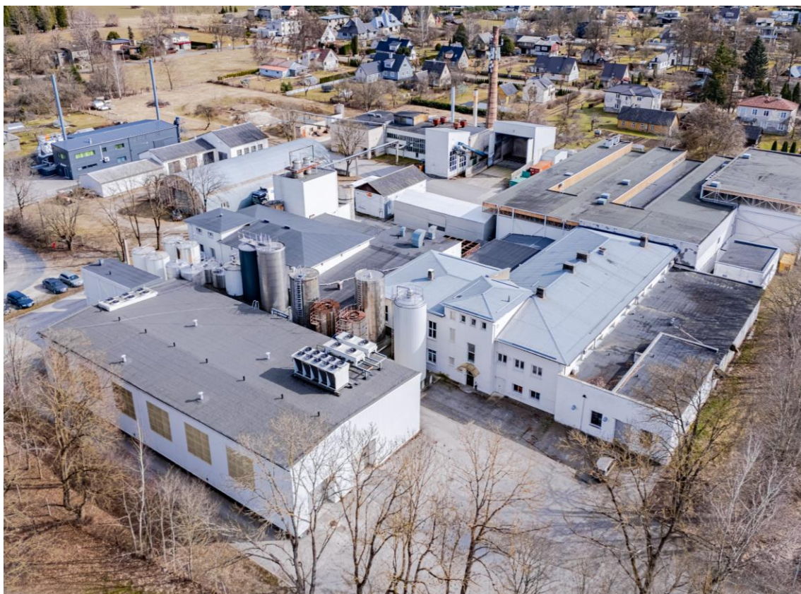
Põltsamaa Production Complex
